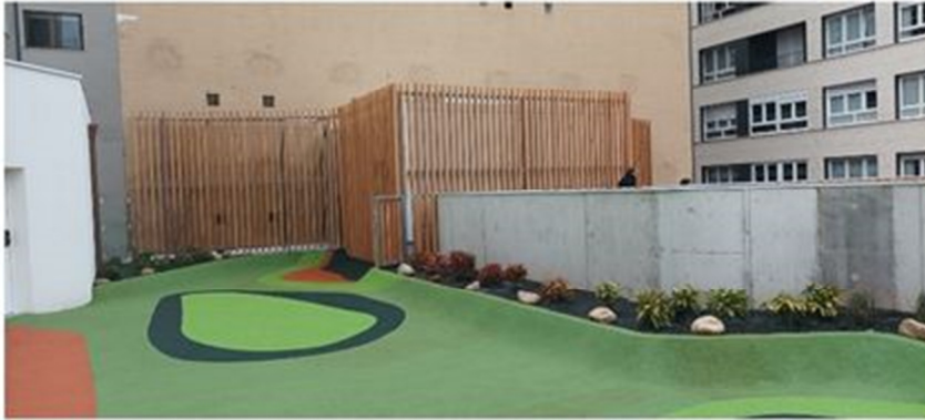
Cubierta transitable de la Ampliación
