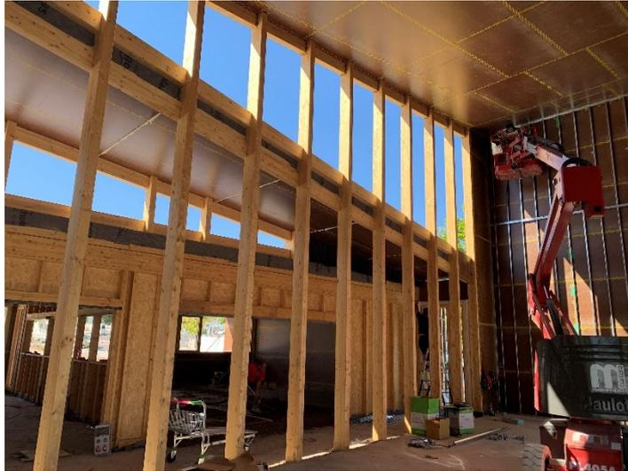
Imagen 4: Vista proceso montaje entramado ligero
